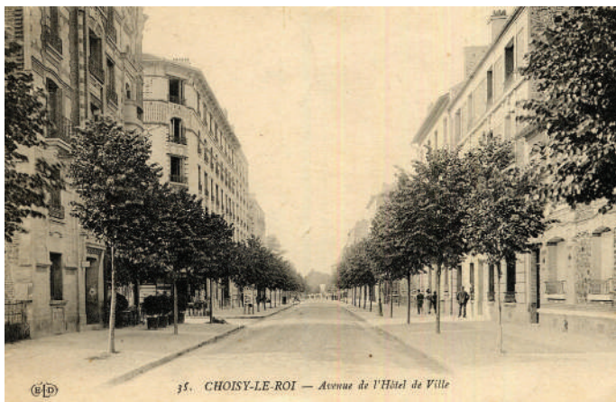
La construction de l'avenue de l'Hôtel de Ville. Archives communales de Choisy-le-Roi.
