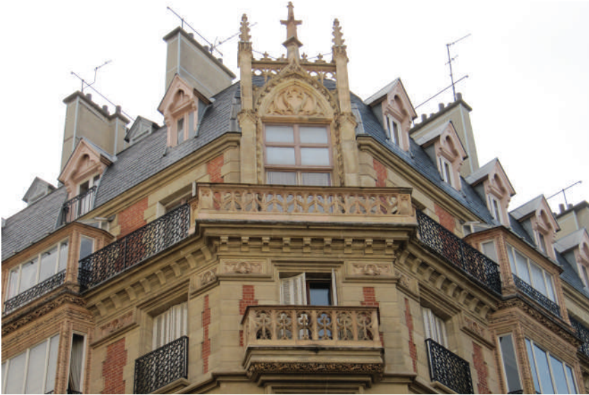
Décor de façade de style néo-gothique en « pierre artificielle », terre cuite imitant la pierre, produits par Garnaud et Brault. Immeuble au n° 3 rue Le Goff à Paris. Photographies Françoise Mary
