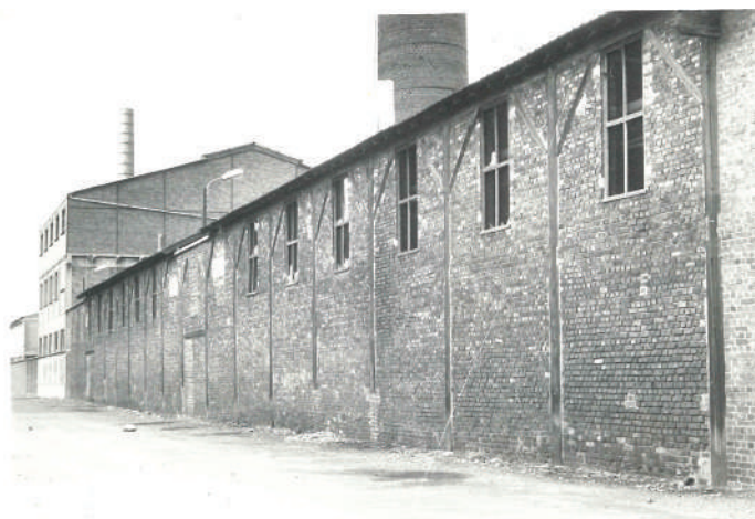
La tuilerie et l'usine de carreaux de grès de Vitry-sur-Seine. Archives communales de Choisy-le-Roi / Fonds Hélène Bougie
