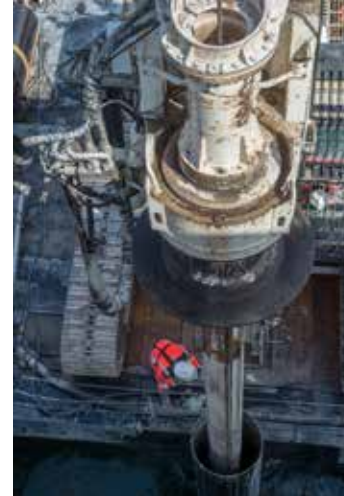
Technique du vibrofonçage employée pour créer les fondations de la passerelle
