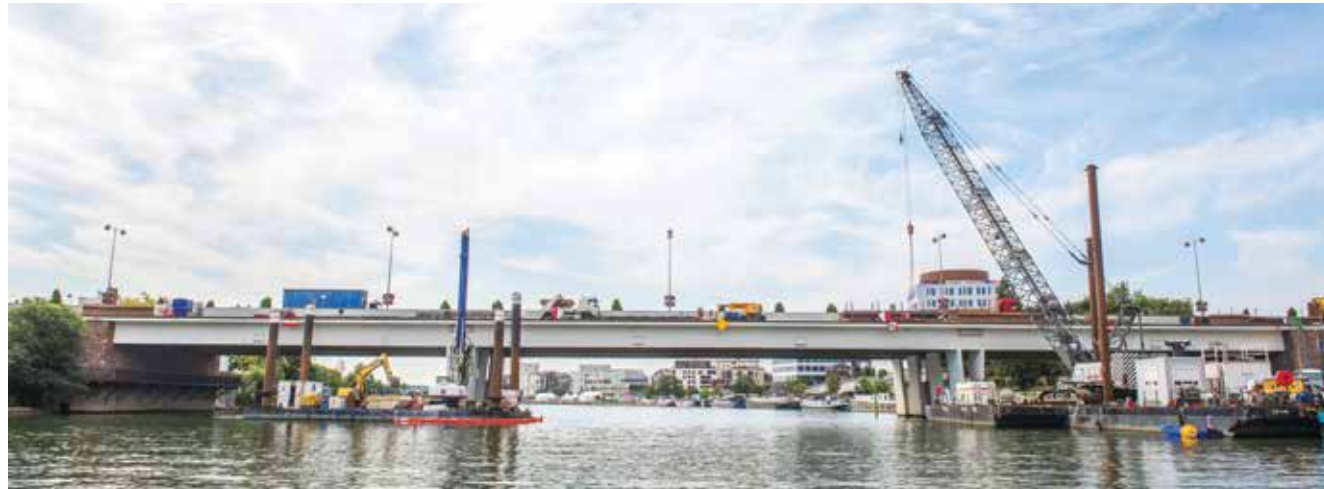
Technique du vibrofonçage employée pour créer les fondations de la passerelle
