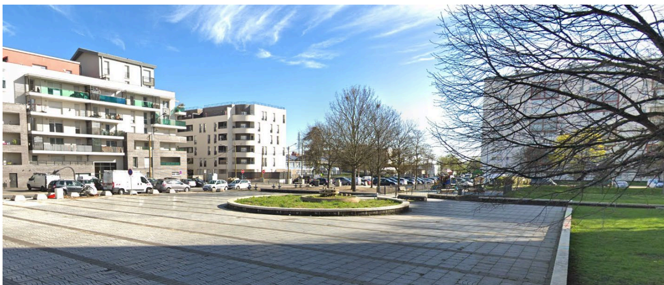
FIGURE 3 PHOTOGRAPHIE DU SITE AVANT TRAVAUX
